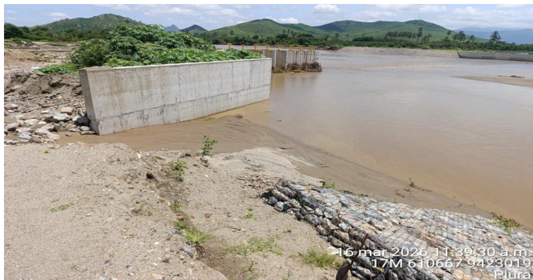
FIGURA N°02: TRAMO CRÍTICO PARA PROTECCIÓN CON DIQUE ENROCADO EN EL RIO PIURA, EN EL SECTOR LA TOMA, DISTRITO DE BUENOS AIRES, PROVINCIA DE MORROPÓN - PIURA. SE VISUALIZA TRAMOS CORTOS SIN ENROCADO ANTE UNA MAXIMA AVENIDA
